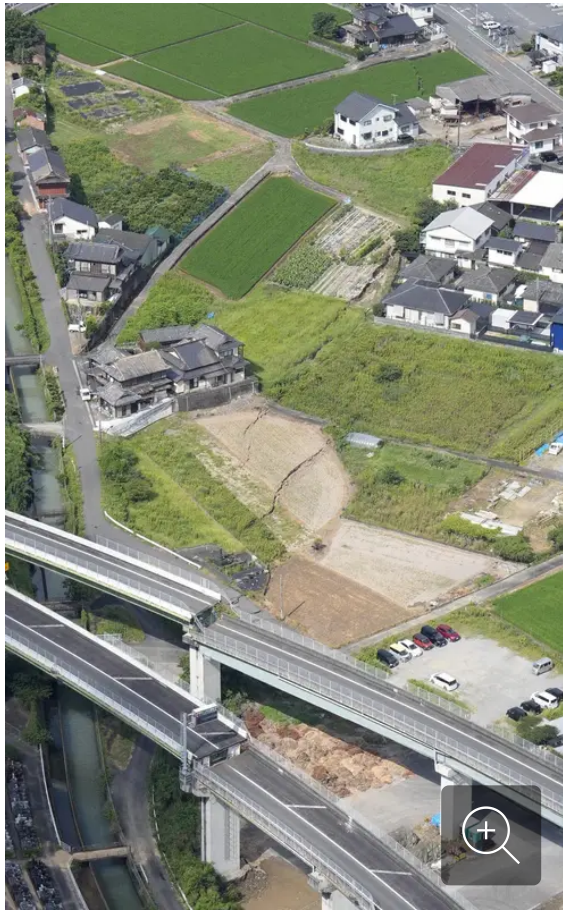
地震後に現れた地割れ。手前は南九州自動車道＝熊本県八代市で2026年7月29日午前9時22分、本社ヘリから
