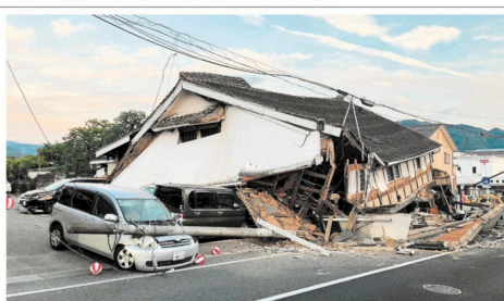
地震で倒壊した民家＝28日午後、氷川町
