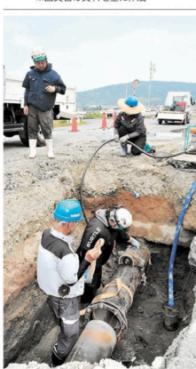
2026年熊本地震で破損した水道管の復旧工事に汗を流す民間業者ら＝4日午前11時ごろ、宇城市小川町
