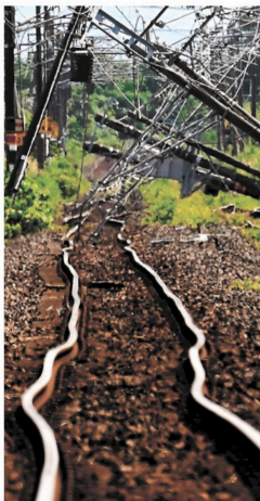
ゆがんだJR鹿児島線の線路。電柱も斜めに倒れていた＝5日午後2時50分ごろ、氷川町（小野宏明）
