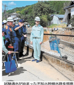
試験通水が始まった不知火幹線水路を視察
