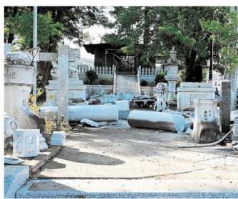
震度6強の揺れで鳥居や灯籠、玉壇などが倒壊した惣領神社の境内＝7月31日、益城町
