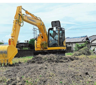
八代市鹿倉町の市有地で始まった建設型仮設住宅の建設作業＝11日
