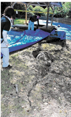
人吉城跡本丸の地割れ。中央部の石は、かつて護摩堂があった場所にあった礎石＝24日
