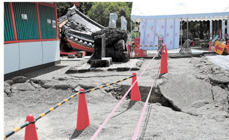
2026年熊本地震で、境内に亀裂が入った八代神社(妙見宮)。八代市(江崎明)
