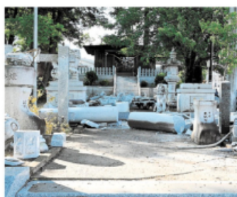
震度6強の揺れで鳥居や打鐘、玉座などが倒壊した惣領神社の境内＝7月31日、益城町
