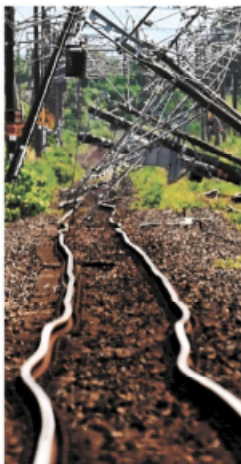
ゆがんだＪＲ鹿児島線の線路。電柱も斜めに倒れていた＝５日午後２時50分ごろ、氷川町（小野宏明）
