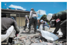
被災家屋の屋根から落ちた瓦を土のう袋に集める
