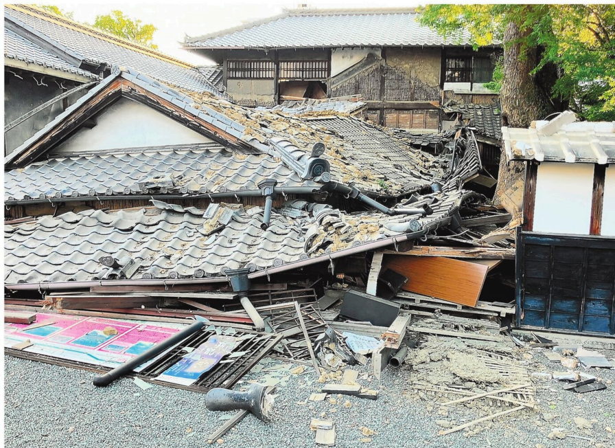
建物が倒壊した八代市の国指定名勝「松浜軒」の御茶屋＝28日午後5時55分ごろ、八代市北の丸町
